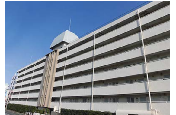
外観 平成30年4月撮影
